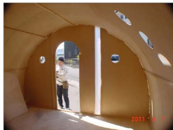
19・ドア枠補強作業中
