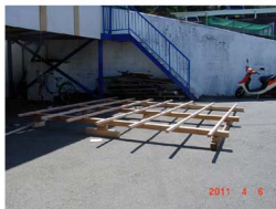
1. 土台(90mm角) 根太45mm角@600の施工
