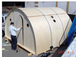
15・ドアパネル（切り出し材）取り付け
