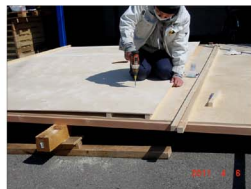
3. 床面でドームパネルの組立 *6.5mm合板3枚を30mm角材2本で連結(木ねじ)
