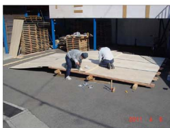
5. 両側壁面パネルにトップ用の合板を縫い付け。 補強の30mm角材3本も追加
