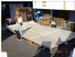
7・ 完成したドームパネルの片側（この場合は右側）を 根本側のストッパーブロックに当てて建て起こしを 開始。*女性の力ではやや不足
