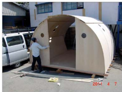
13・妻壁パネルの取り付け（パネルは加工済みまたは型紙支給）
