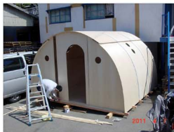
14・ドア回りパネル取り付け。
