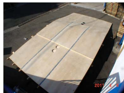
6. 組みあがったドームパネル(3660×6720 約130Kg) *合板接合部には防水テープ貼り
