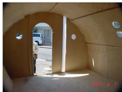
20・内部の補強 30mm 角材の位置に罫目 *この部材を頼りに新熱材や内部造作を取り付け
